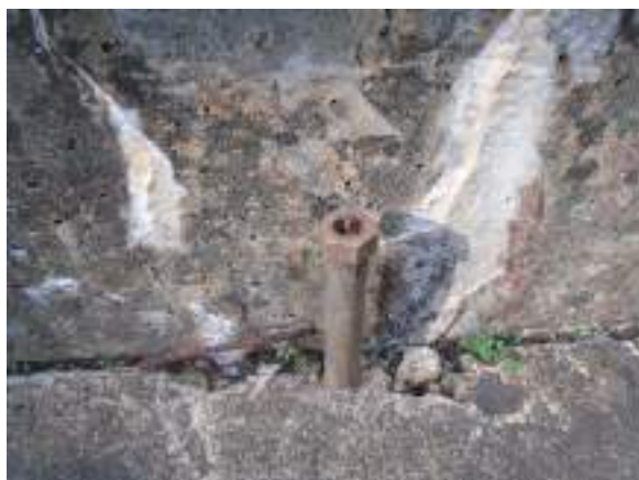
Foto 1 – C-3303 – Cabo Rompido
