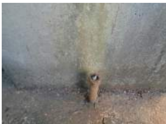
Foto 1 – E-3318 – Cabo Rompido
