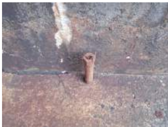
Foto 2 – C-3302 – Cabo Rompido
