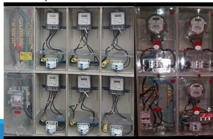
Medição Frontal em Mureta
