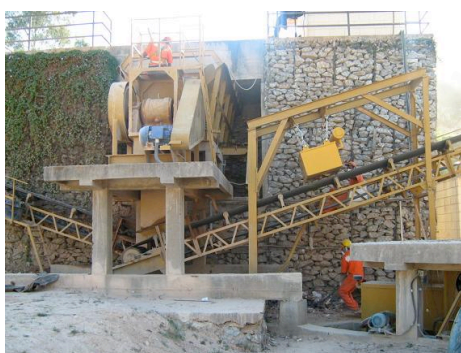
Figura 3 - Britador de mandíbula + peneirador mecânico + correia transportadora + eletroímã
